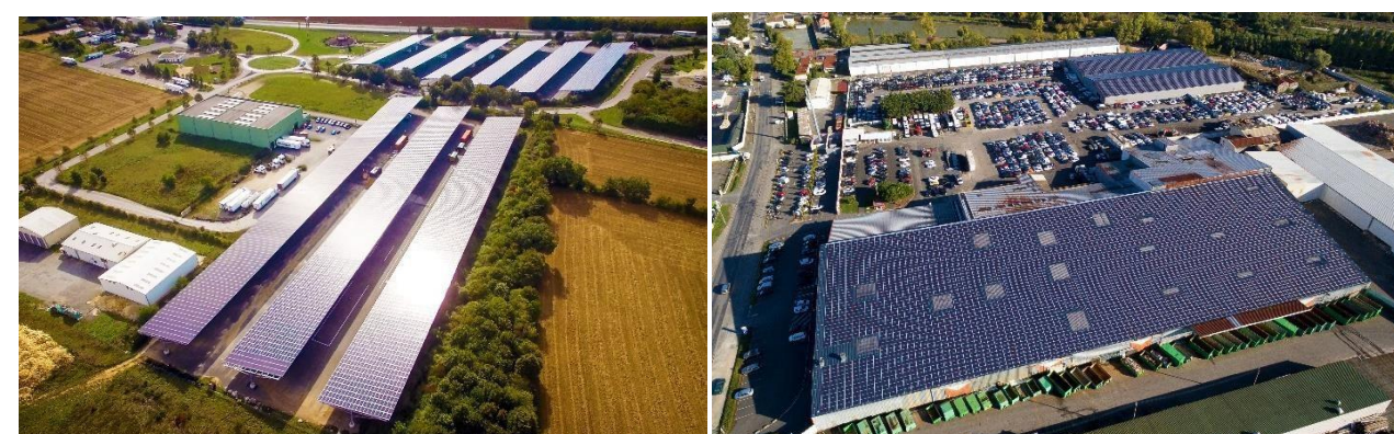
Figure 7 : Ombrières à gauche et panneaux en toiture à droite (Deux-Sèvres).
